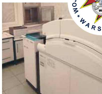
Hermetyczna szufla podawcza. Z chwilą otwarcia drzwiczek od strony laboratorium blokada uniemożliwiająca otwarcie drzwi od strony osoby dostarczającej materiał. Cały mechanizm posiada sygnalizację dźwiękową.
