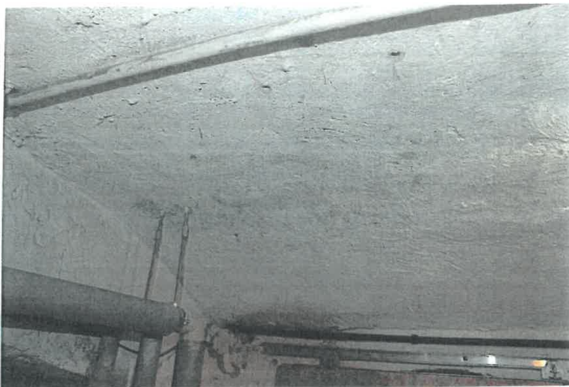
Fotografia nr 74 – Widok stropu w pomieszczeniu piwnicy. Na powierzchni stropu piwnicy nie są widoczne zawilgocenia po zalaniu w budynku.
