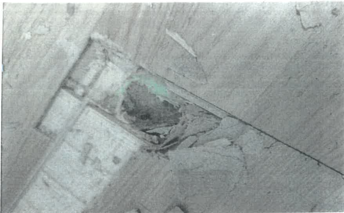
Fotografia nr 72 – Widok płyty pilśniowej miękkiej poniżej drewnianych trójwarstwowych paneli podłogowych w pomieszczeniu nr 102.
