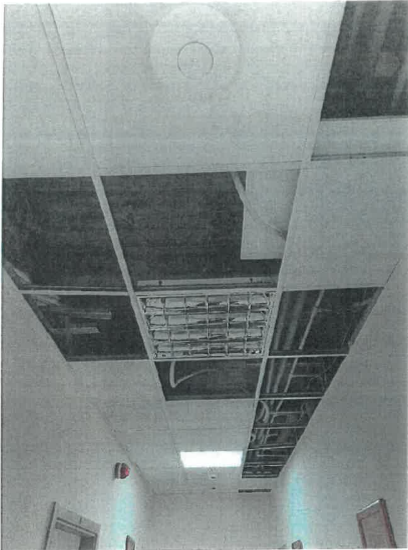
Fotografia nr 32 – Zawilgocone porowate elementy stropu podwieszanego w obrębie korytarza czwartego pietra.
