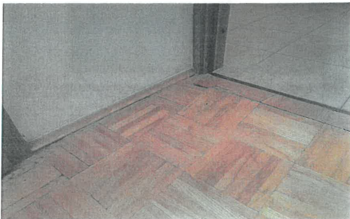
Fotografia nr 47 – Widok uszkodzonej posadzki z mozaiki dębowej po zalaniu w pomieszczeniu nr 403.2
